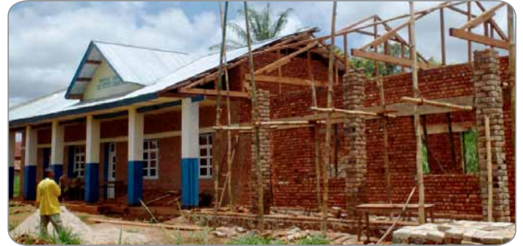
Construction de la troisième classe
