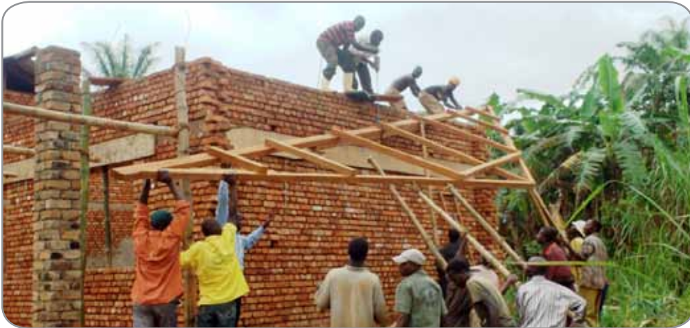
Maçons, charpentier et un groupe des jeunes en train de soulever la charpente pour la placer.
