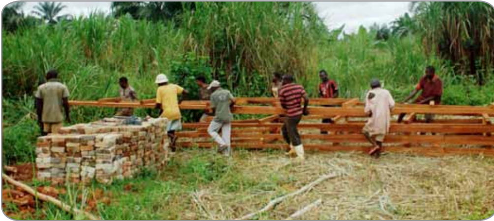
Maçons, charpentier et un groupe des jeunes en train de soulever la charpente pour la placer.
