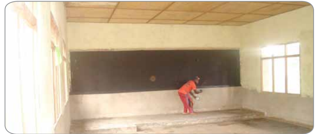
Travaux de finition de la deuxième classe
