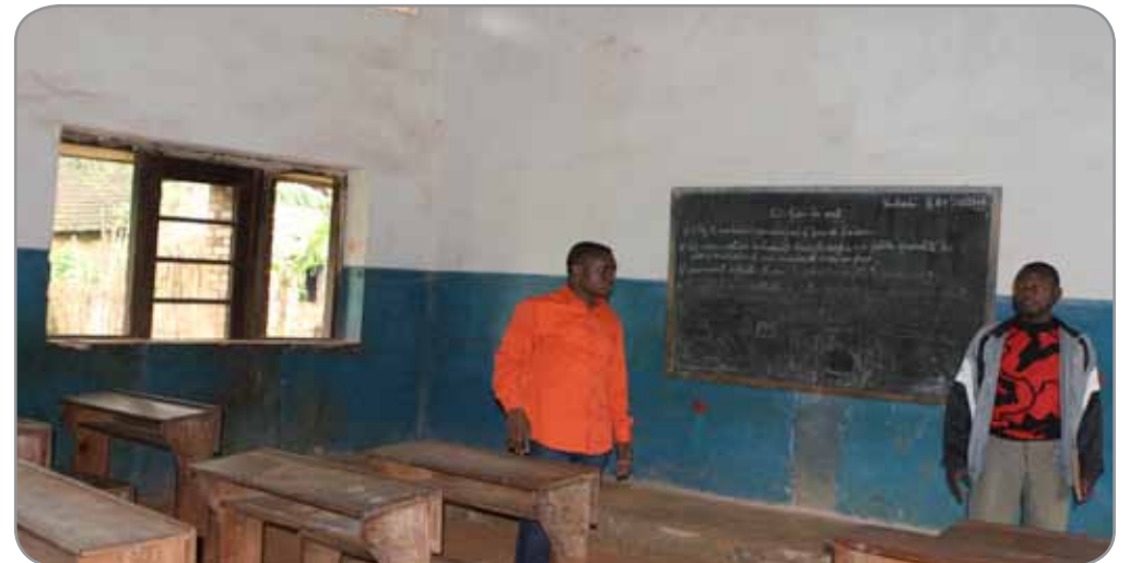
Classes en cours de rénovation
