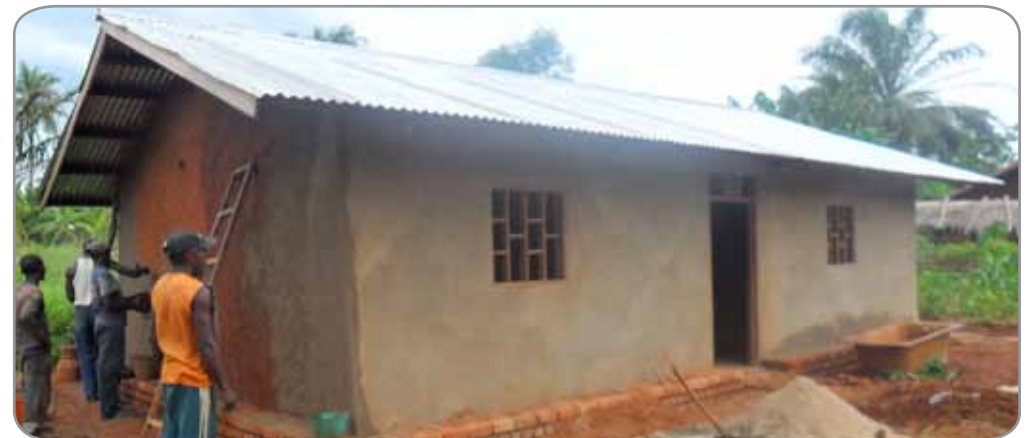
Construction d'une nouvelle maison pour un enseignant
